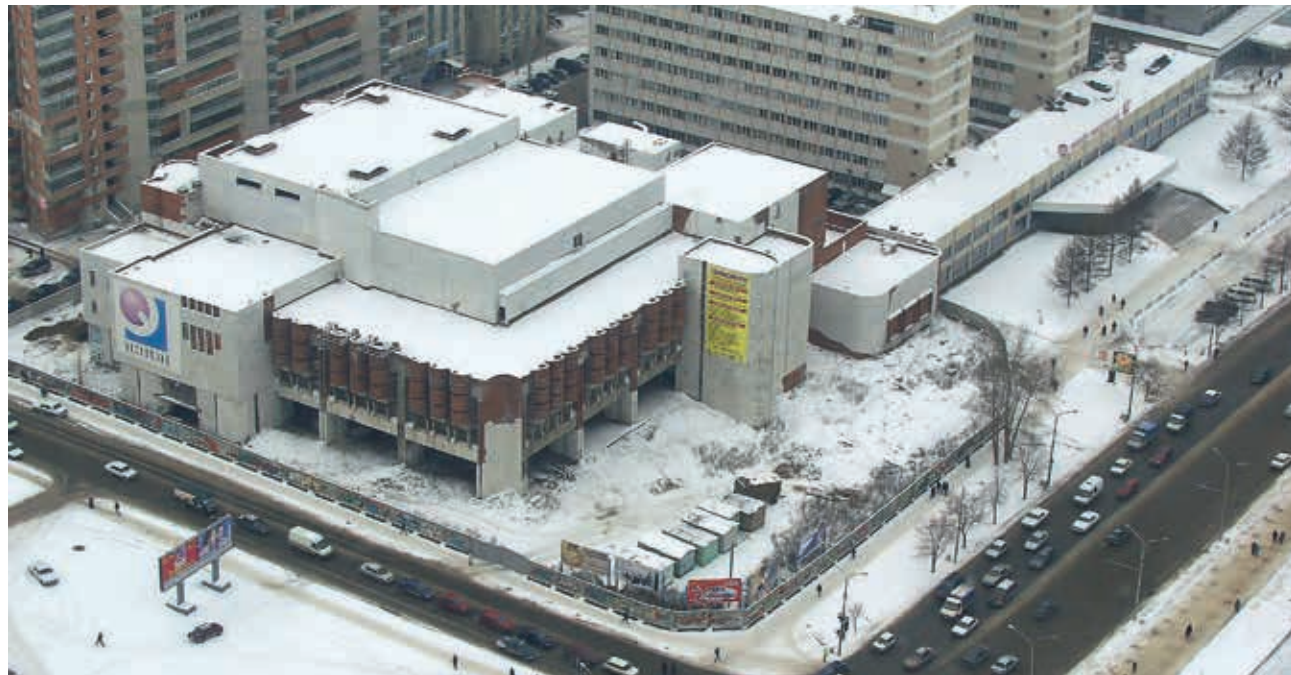
Недострой концертного зала. Будущий ТЦ «Козизей»
